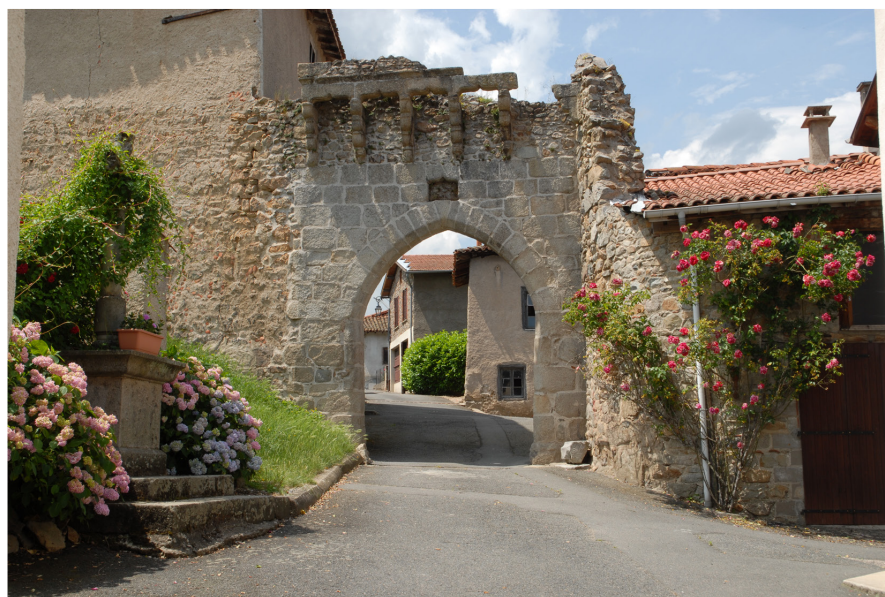
Porte de Boën à l'Hôpital-sous-Rochefort
